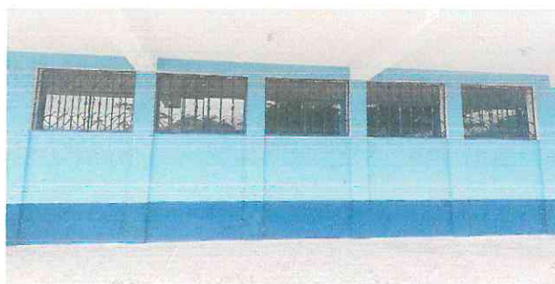
Foto 3: instalacion de balcones por seguridad. FINALIZADO
