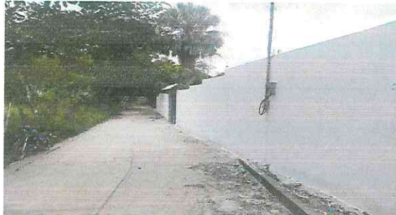
Foto 1: Aplicación de repello y cernido a muro perimetral. FINALIZADO
