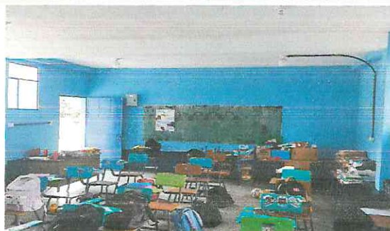
Foto 4: Instalación de caja de 6 filipones e instalacion de toma corrientes. FINALIZADO
